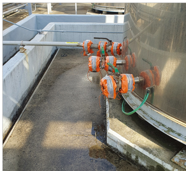
유해화학물질 배관 플랜지 누출 방지 커버 설치
