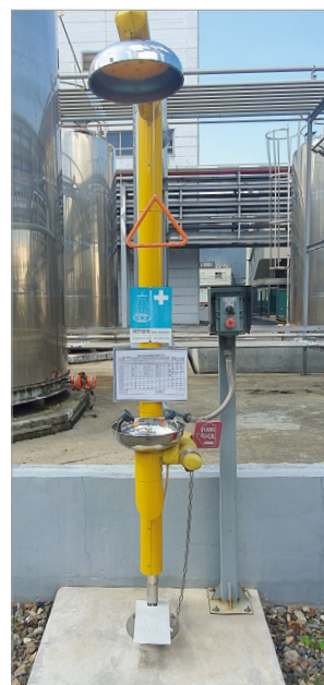
비상 샤워기 동파 방지 장치 설치
