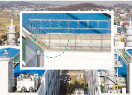
생산동 옥외 상부 안전난간대 설치 완료
